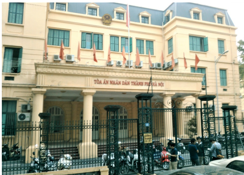
（ハノイ市人民裁判所庁舎：正面玄関 通常、正面入り口は使用されていないようであり、建物右側の通用門から入って庁舎建物の右側面から出入りするようである。）
