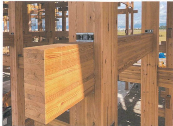
（左が清水の舞台の「貫接合」、右が大屋根リングの「貫接合」の例）
