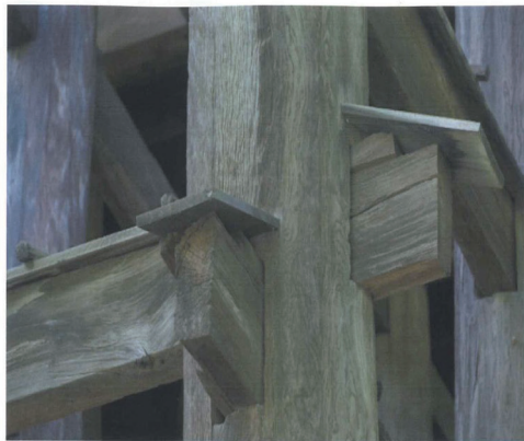
（左が清水の舞台の「貫接合」、右が大屋根リングの「貫接合」の例）
